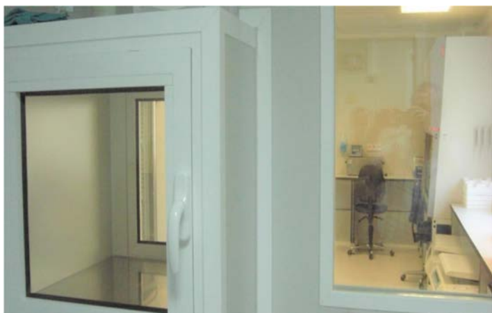
Esclusa paso de medicamentos, con enclavamiento.
