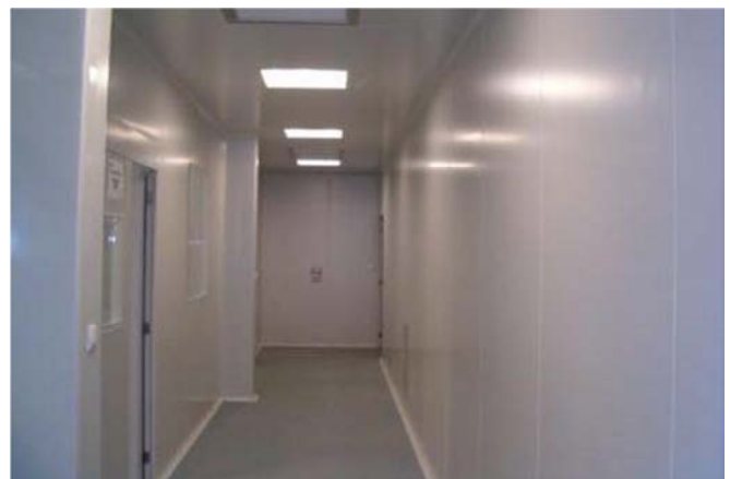
Vista interior pasillos (2).
