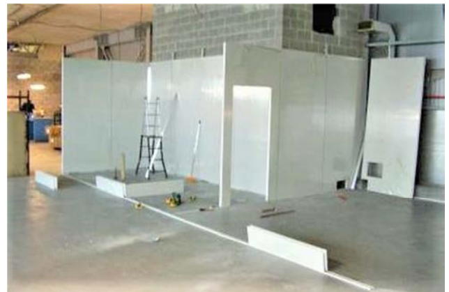
Fase replanteo distribución Sala.
