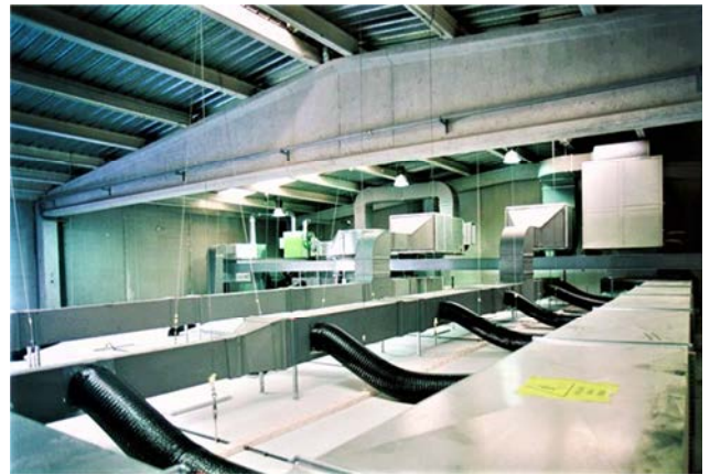
Fase techo transitable.
